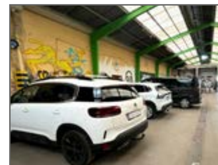
Der derzeitige Eingang mit Parkplatzüberdachung
